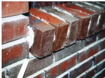
*Vor der nachträglichen Verfügung durch die Bauleitung zu prüfen: Feuchtigkeitssperre unter gemauertem Rollschicht der Fensterbank.*
